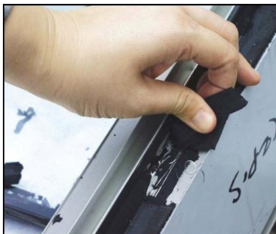
Рис. 17: Удаление остекления (расстекление)
